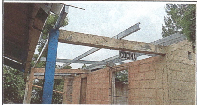
Foto 10: Remozamiento estructura de techo de madera a estructura metálica de la cocina y su corredor.
