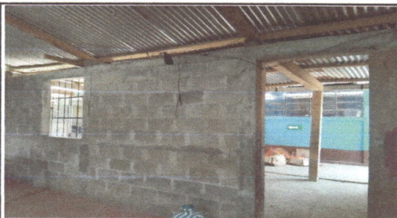
Foto 3: Remozamiento de puerta de madera por una puerta de metal para la cocina.
