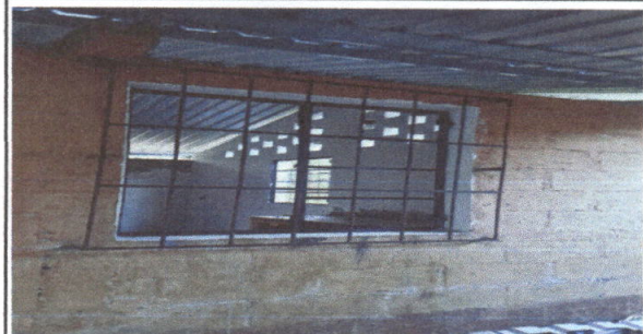
Foto 2: Remozamiento de 4 ventanas de la cocina
