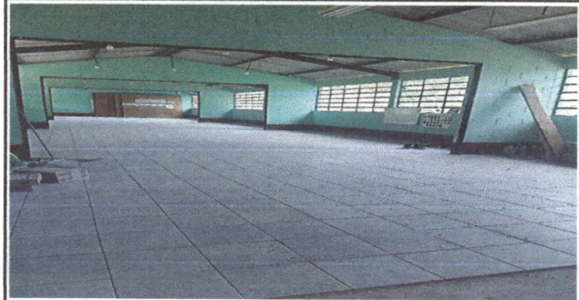
Foto 8: Remozamiento de piso alisado a piso ceramico de 4 aulas
