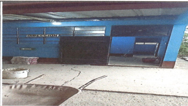
Foto 9: Remozamiento de piso alisado a piso ceramico dirección y bodega.
